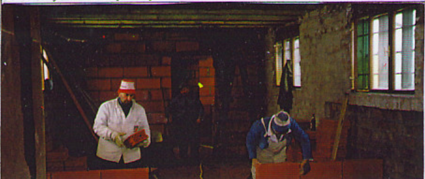
A ovdje su zidarski radovi u tijeku, donje prostorije VK Croatia.
