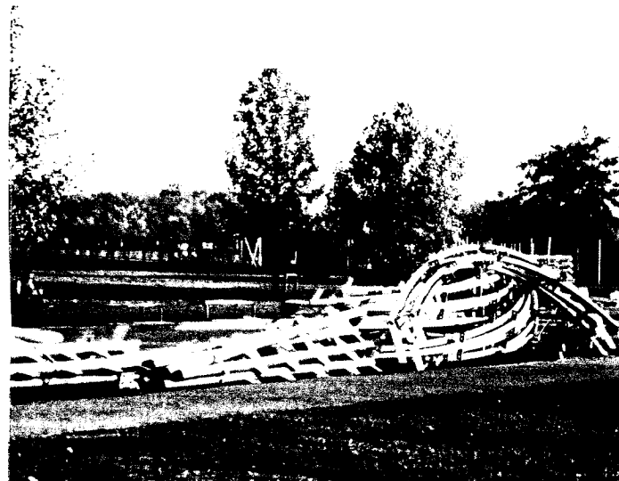
Istovareni stupovi i noseće grede na Jarunu.
